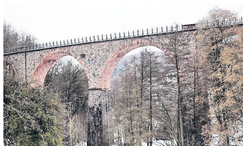
Hervorragend in Schuss – so das Urteil über das Gestein bei den Viadukten entlang der Draisenbahn-Strecke.
