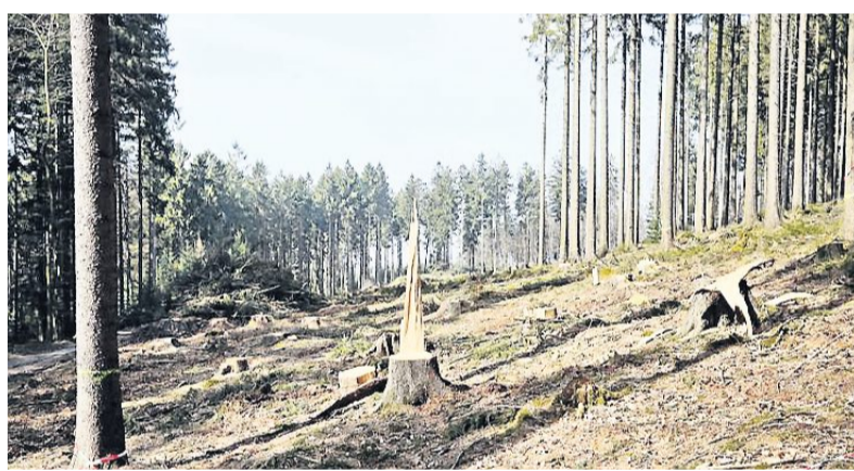
Alles kahl: Die Rodungsarbeiten am Stillfüßel sind abgeschlossen. In den nächsten Tagen beginnt laut Entega die Abfuhr des Holzes.
